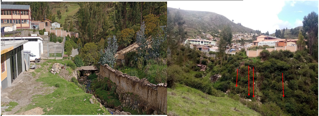
Elementos expuestos, población y viviendas en la margen izquierda de la quebrada
