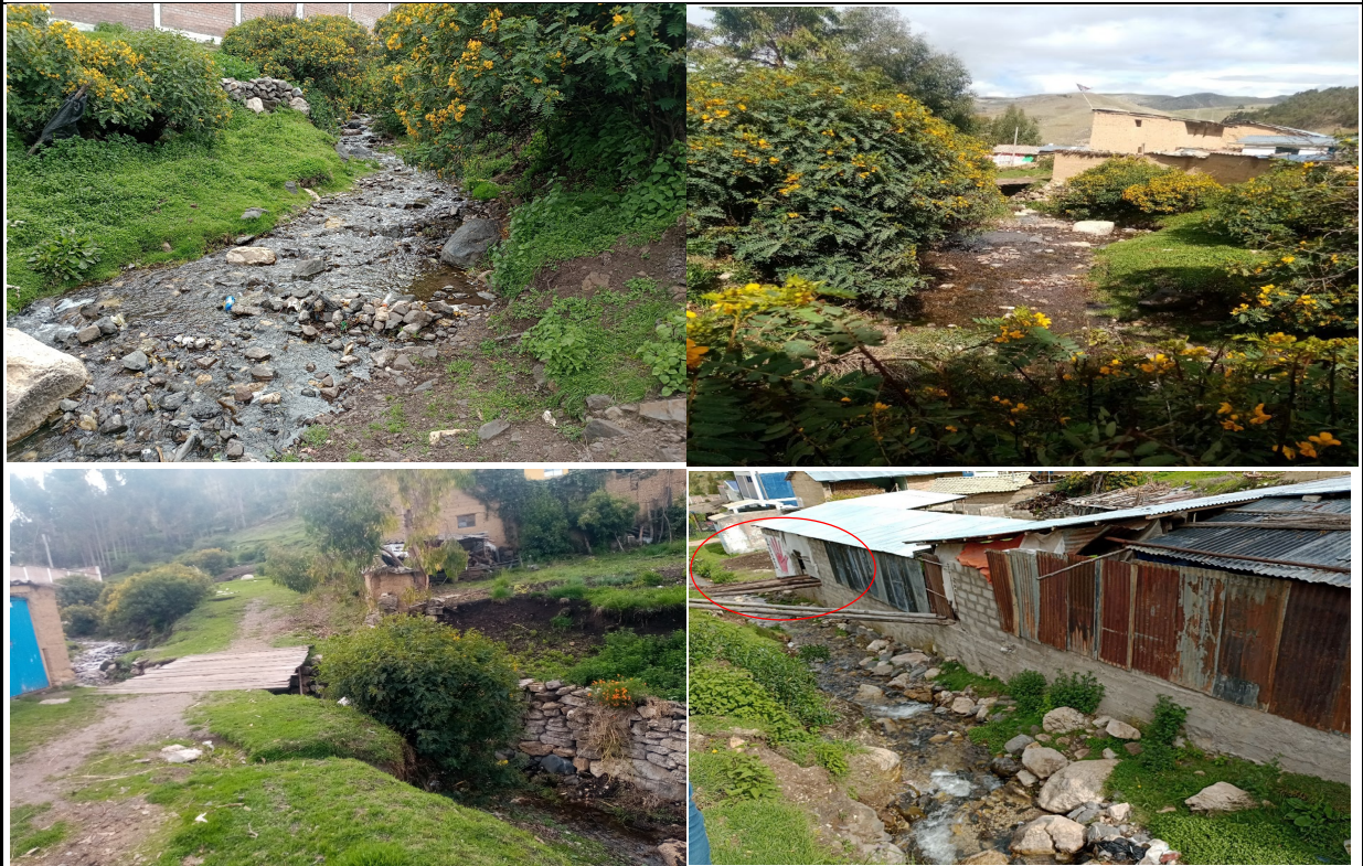
Colapso del puente Chancharamani, desborde y colmatación de la trocha carrozable
